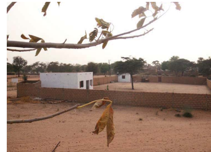
Detall del recinte del centre de salut.
